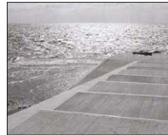
In-situ støbte pladeur
