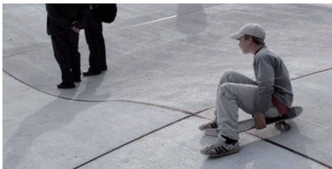
Dobbeltkrum insitu-støbt betonbelægning. Reference USF-plassen, Bergen
