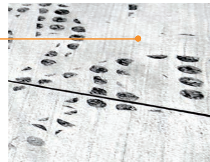
Afsyret betonoverflade. Reference Walker Artmuseum, MN
